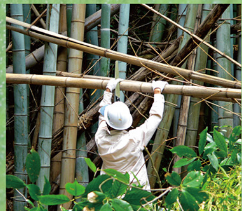
▲複雑に絡み合う枯竹除去作業は危険も伴う
